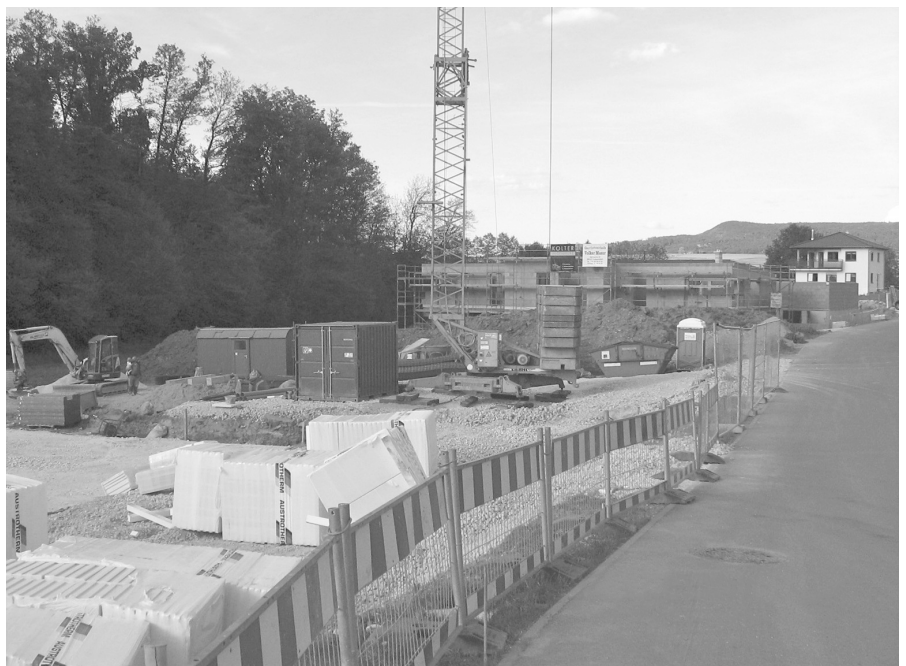
Im Gewerbegebiet „Schlemmerwiesen“ in Pödeldorf dröhnen zur Zeit die Baumaschinen – alle Grundstücke sind verkauft! Anscheinend hat der Gemeinderat hier mal wieder ein glückliches Händchen bewiesen und einen wichtigen Baustein für Litzendorf's Zukunft gelegt.
